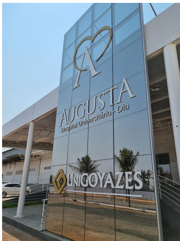
FIGURA - FOTO DA FACHADA
