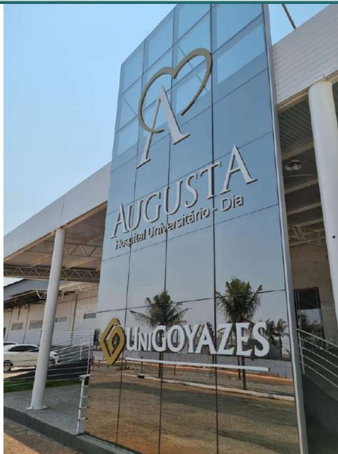
FIGURA - FOTO DA FACHADA
